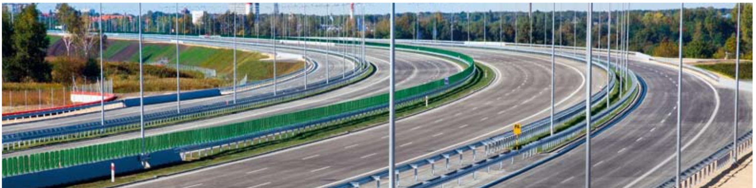
Autostrada A1, węzeł Sośnica – węzeł Maciejów
