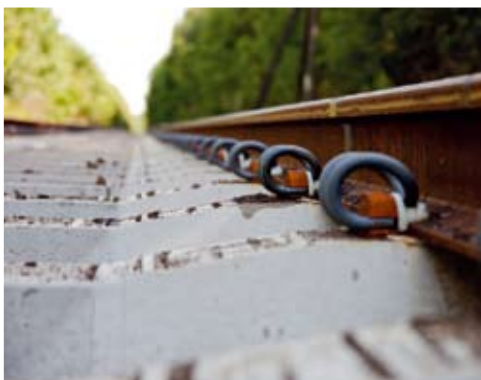
Tor w trakcie modernizacji Track during the modernization
