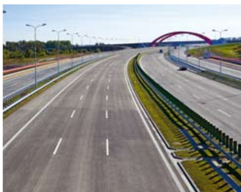
Autostrada A1, węzeł Sośnica – węzeł Maciejów Motorway A1, Sośnica junction – Maciejów junction
