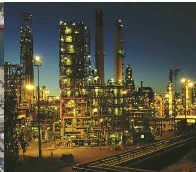
Instalacja Biodiesel dla Porvoo, FINLAND
