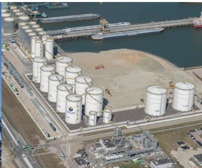
Neste BTT Boltlek Tank Terminal
