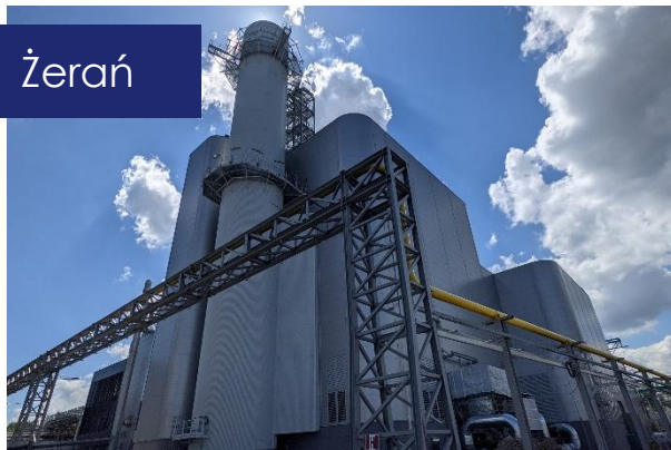
Blok gazowo-parowy w EC Żerań w Warszawie 497 MWe
