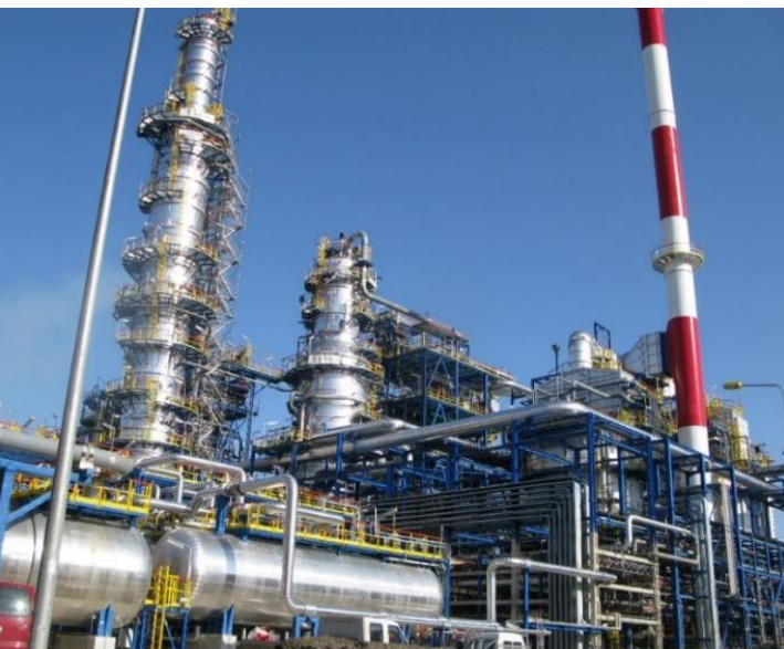
Budowa instalacji CDU/VDU w rafinerii gdańskiej Grupy Lotos (1)
